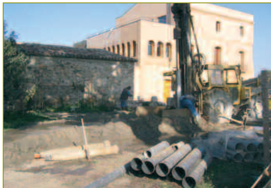
■ La masia tenia mancances tant d'ordenació com d'adequació dels serveis.
