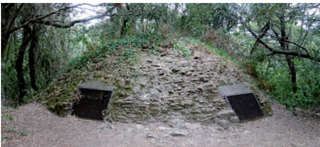
Pou de glaç de l'Estepar (6 m de diàmetre, 8 m de profunditat i 232 m 3 de capacitat) construït l'any 1706
