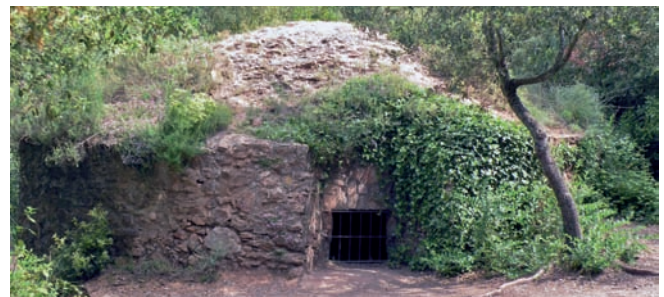
Pou de glaç de la Portella (5 m de diàmetre, 6 m de profunditat i 155 m 3 de capacitat), construït l'any 1760.
