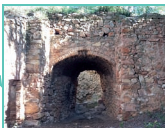
Forn de calç: Forn per coure roca que podia arribar a 1.000 °C
