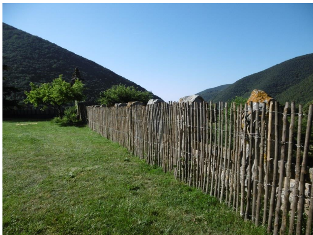
Instal·lació de tanca de castanyer a l'era de la masia de Vallfornès.
