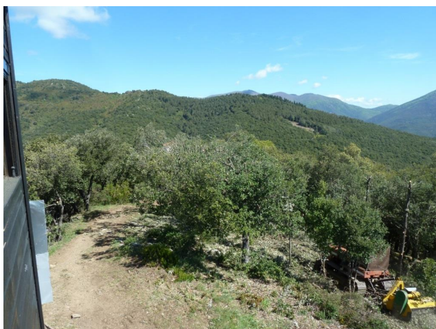
Desbrossament al voltant de la torre de guaita de Sant Elies.
