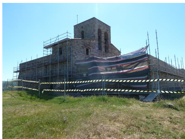
Restauració de l'església de Santa Maria de Tagamanent.
