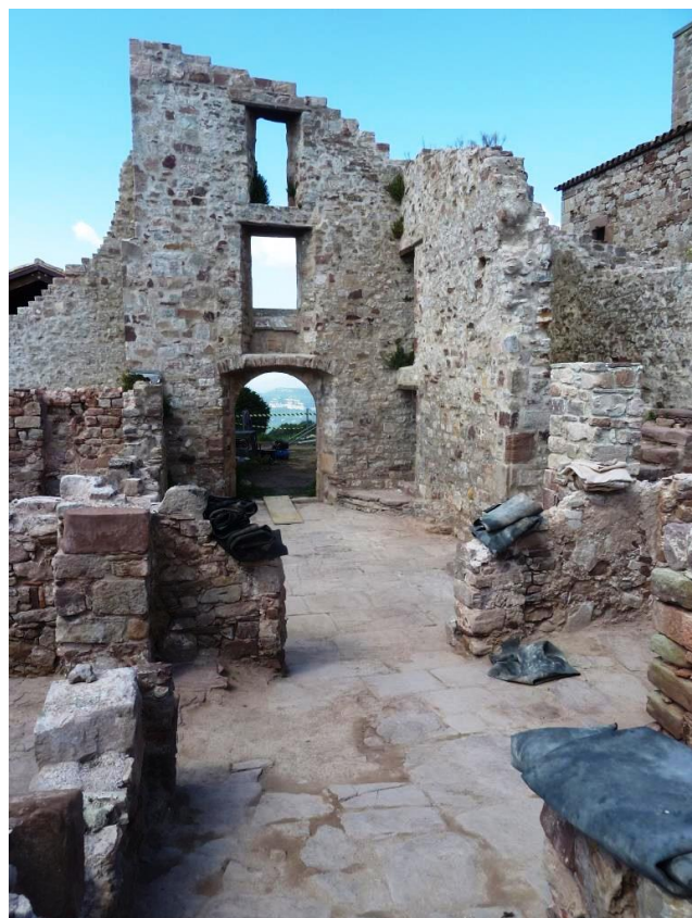
Restauració i consolidació de les restes
