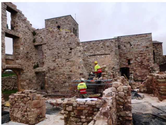
Restauració i consolidació de les restes arquitectòniques de la casa rectoral i antic ajuntament.
