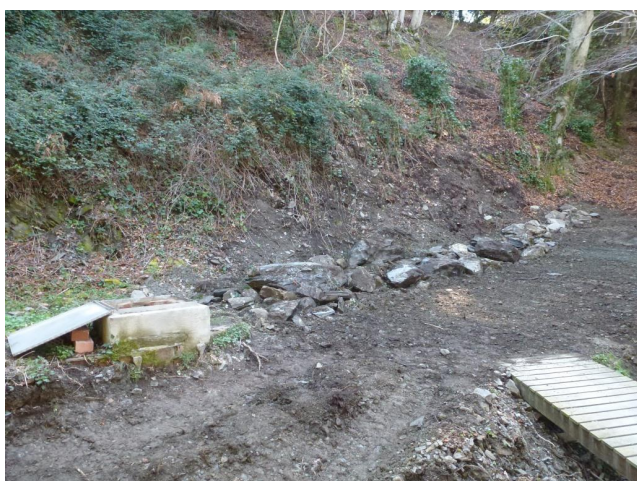
Millora de la captació de l'aigua de la font de Faig.
