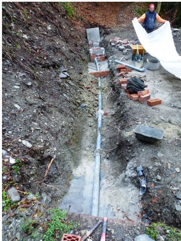
Millora de la captació de l'aigua de la font de Faig.
