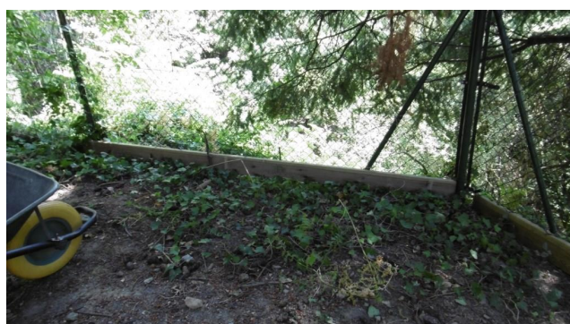
Instal·lació d'un tram de la tanca del càmping de Fontmartina del Parc Natural del Montseny.
