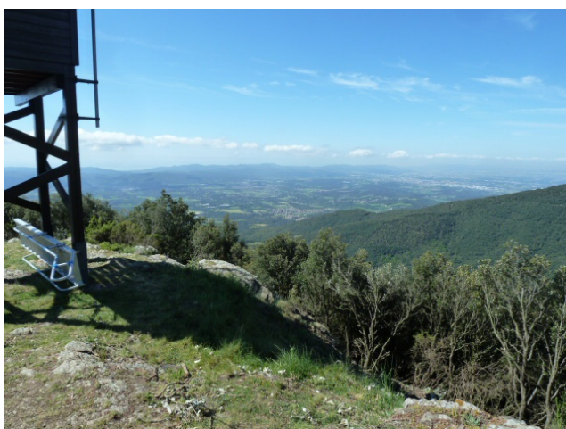
Torre de guaita de Sant Elies.
