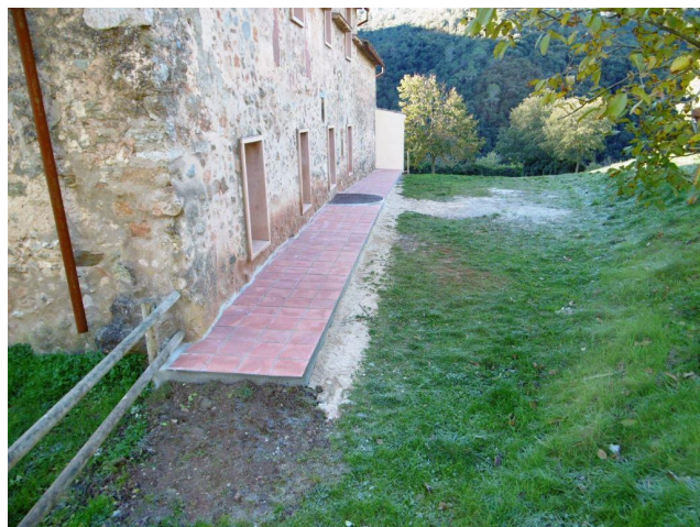
Construcció d'una vorera en la façana nord de l'Escola de Natura Rectoria de Vallcàrquera.
