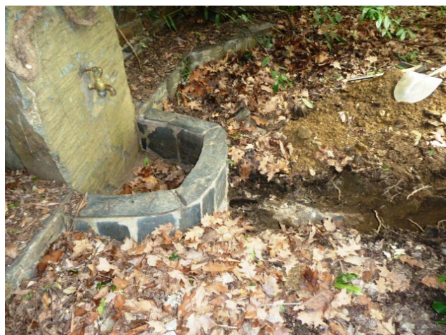
Reparació de tres fonts al càmping de Fontmartina.
