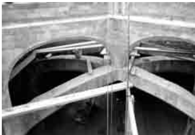
Fotografia 4. Arcs de formigó armat que suporten el cimbori.
