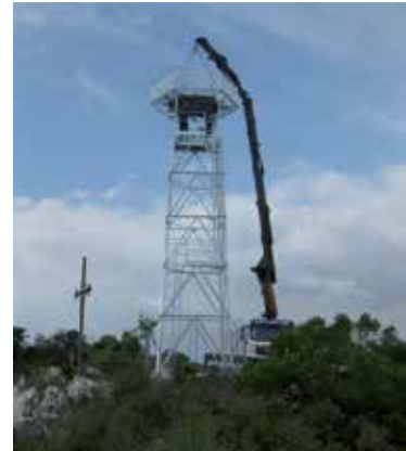
Construcció de la torre de puig de l'Àliga
