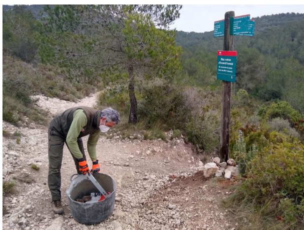
Reparació de senyals. Font: Arxiu XPN
