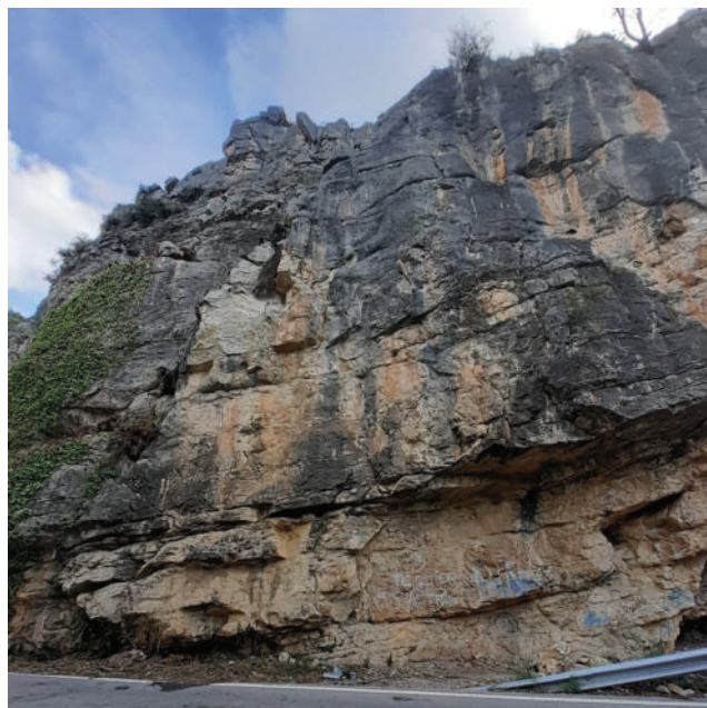
Figura 1. Zona d'obres d'estabilització del talús de la carretera BV-2115. Font: E.Valbuena-Ureña.
