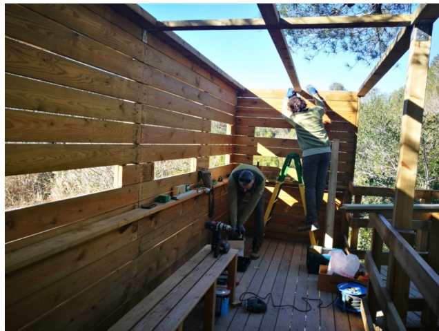
Treballs de construcció de l'observatori.
