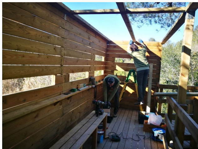
Treballs de construcció de l'observatori. Foto: Arxiu XPN
