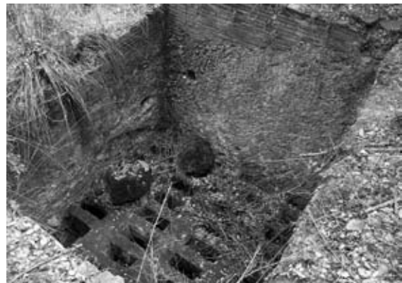
Figura 11. Tapa superior del forn, amb l'enreixat de maons que s'assenta sobre els arcs de diafragma i els arcs en espiga. Pel que fa a les parets, són excavades a la roca, excepte en alguna part superior, on la paret es va completar amb maons. Foto: Josep Campmany.
