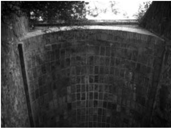
Figura 8. Detall de la volta del pont, feta amb obra cuita. Foto: Àngel Losada.
