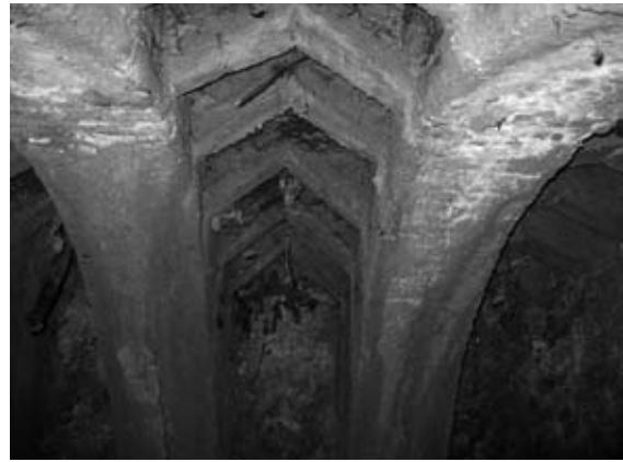
Figura 10. Arcs en forma d'espiga bastits entre els arcs de diafragma. Foto: Àngel Losada.
