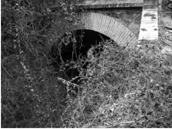
Figura 7. Pont cobert per la vegetació a la part baixa del camí de la Sentiu al castell d'Eramprunyà. Foto: Àngel Losada.
