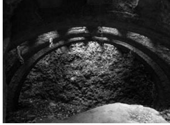
Figura 9. Arcs de diafragma fets amb maons, a l'interior de la rajoleria. Foto: Àngel Losada.
