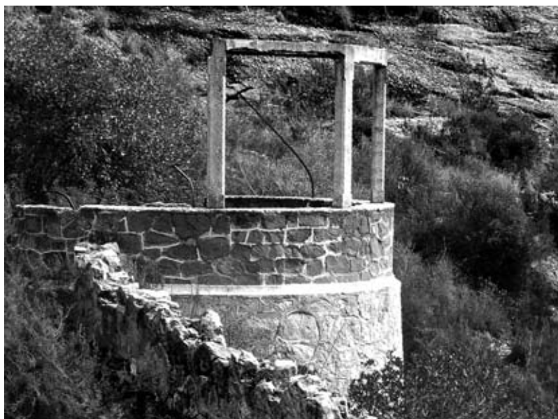
Figura 3. Glorieta situada en un revolt, al tram ascendent des de l'enllaç amb el corriol que puja de can Flocant. Foto: Centre d'Estudis de Gavà
