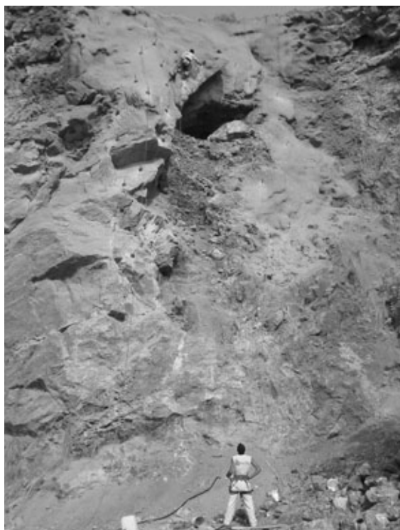
Figura 1. Obres de restauració de la cova del Rinoceront dutes a terme per l'empresa Inaccés.
