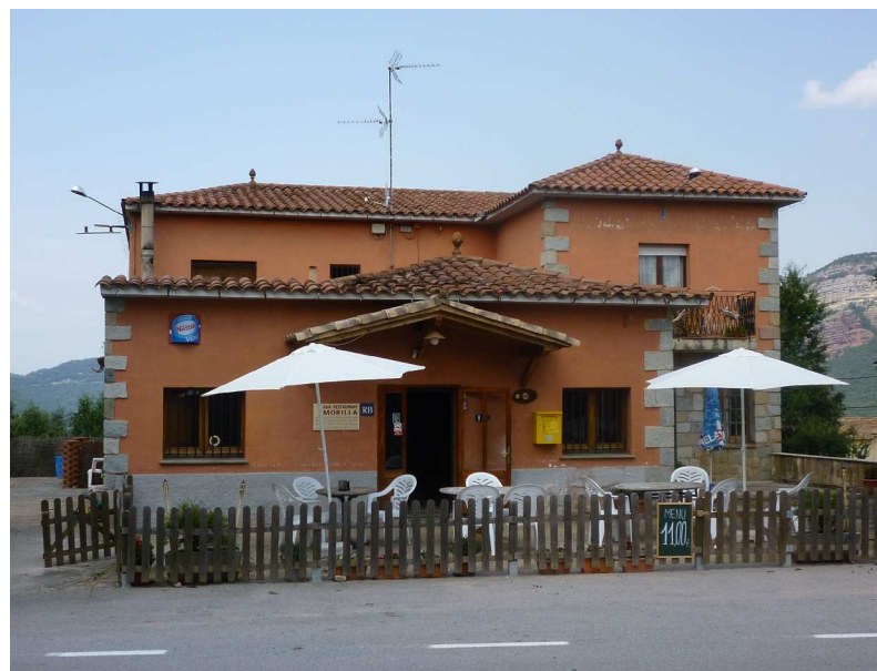
Vista de la façana del Bar Morilla (2010). Autor: XPN
