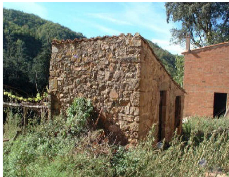
Vista general de la cabana (2001). Autor: XPN
