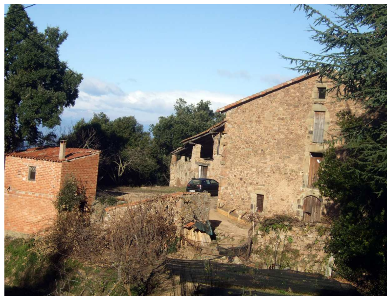
Vista general de la masia amb algunes de les cabanes (2011). Autor: XPN
