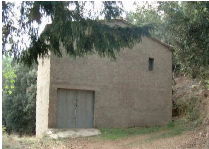
Vista de la casa de Can Gallart (2001). Autor: XPN
