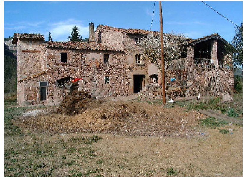
Vista general de la masia (2001). Autor: XPN
