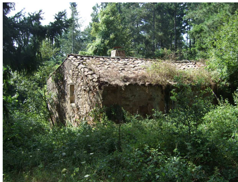
Vista general de la masia (2010). Autor: XPN
