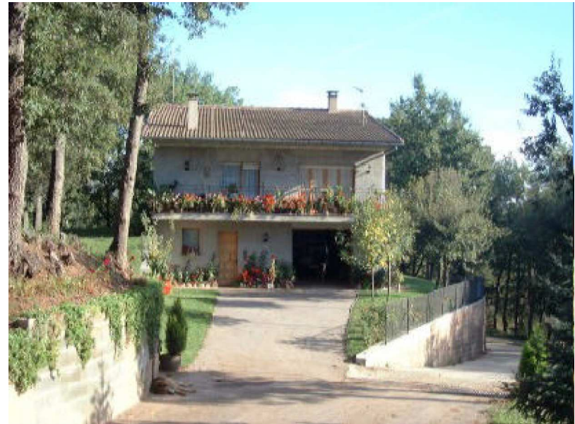
Vista de la façana de can Riera (2001). Autor: XPN
