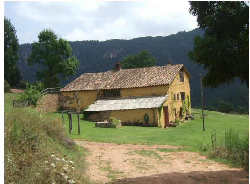
Vista general de la masia (2010). Autor: XPN
