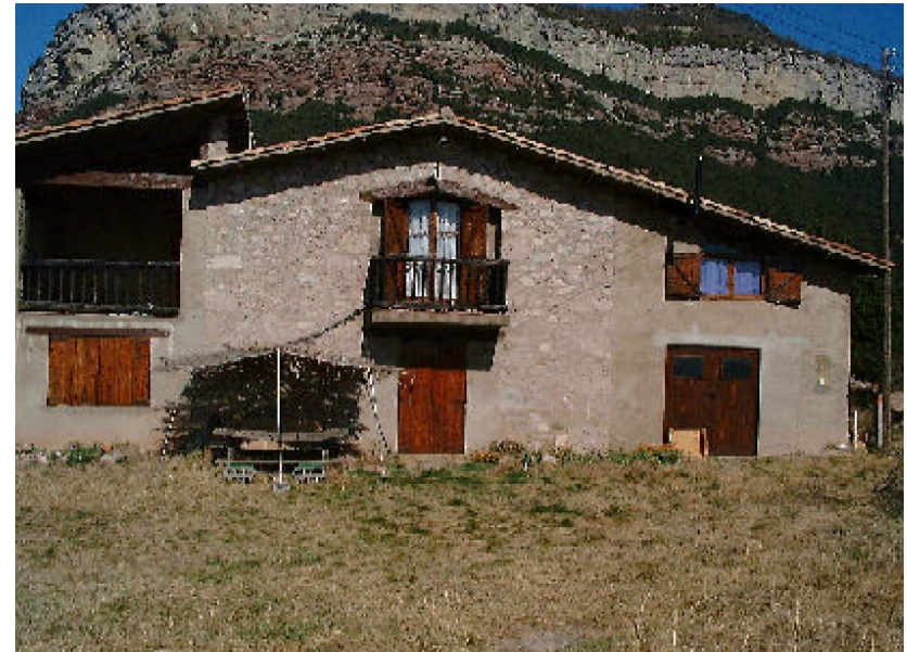
Visat de la façana de la casa (2001. Autor: XPN)
