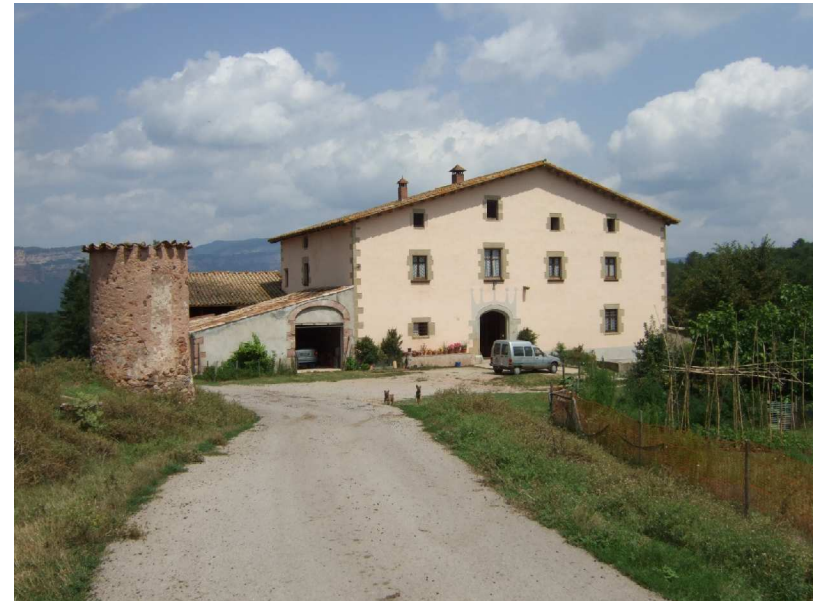
Vista general de la masia (2010). Autor: XPN
