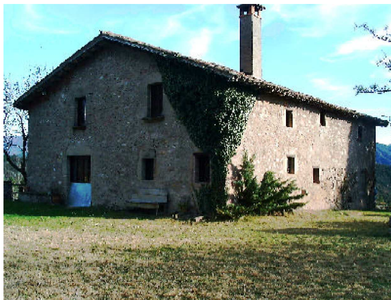
Vista general de la masia (2001). Autor: XPN
