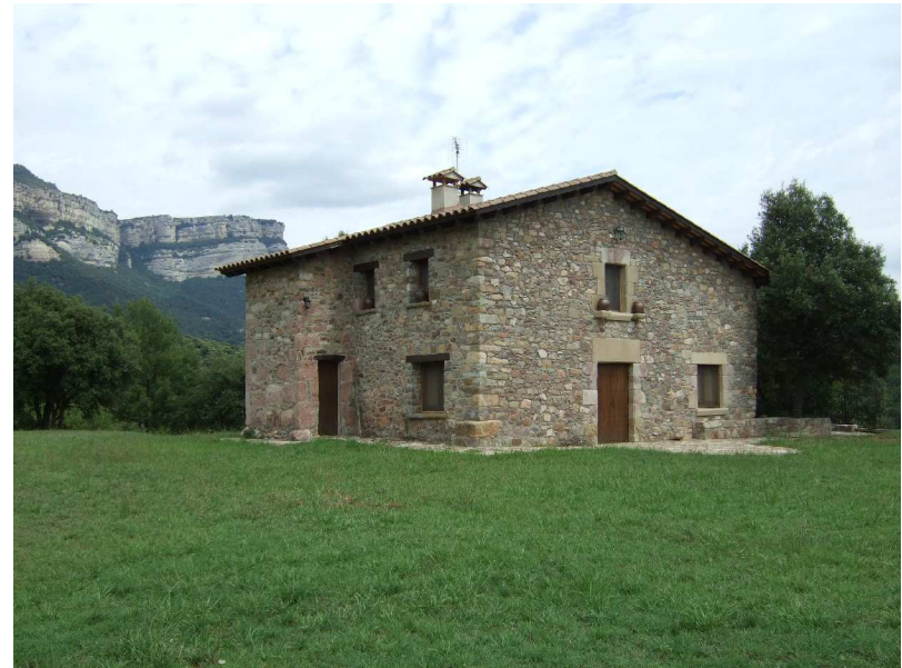
Vista general de la masia (2010). Autor: XPN
