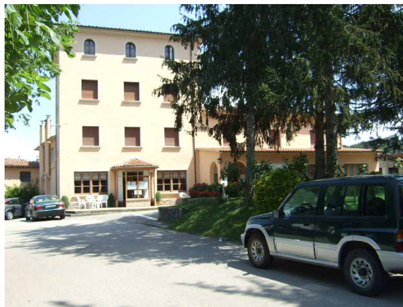
Vista del la façana de l'Hotel (2010). Autor: XPN
