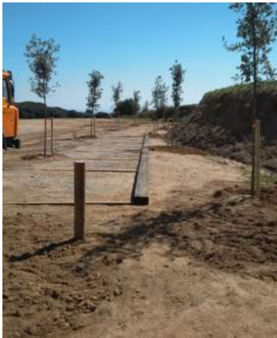
Aparcament de la Roca del Toni -En execució- (Vilassar de Dalt)
