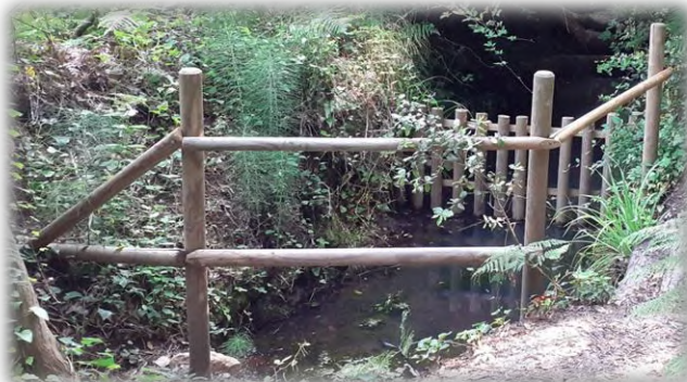
Impermeabilització de la Bassassa (Sta M a de Martorelles)
