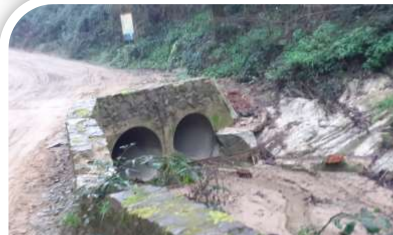
Neteja de tubs i obres de fàbrica
