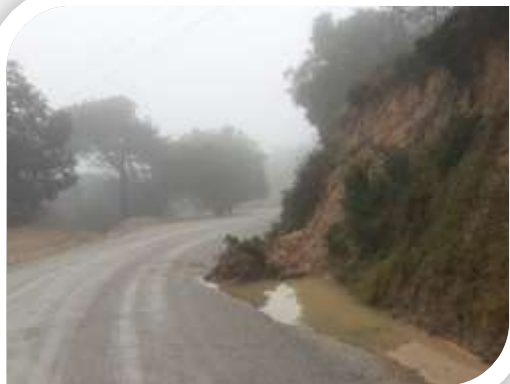
Pista carenera prop dipòsit. Esllavissada. TEIÀ
