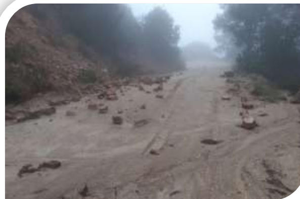
Pista al Turó de Matacabres. Esllavissada. ARGENTONA
