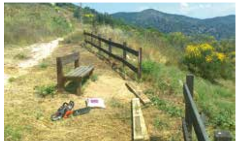
Reparació del mirador de Nou Pins
