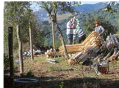
Treballs de construcció d'un tancat a Teià
