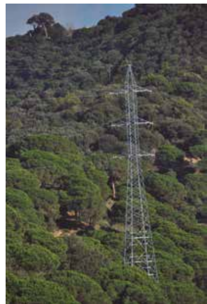
Torre al sector de la pista carenada abans de pintar
