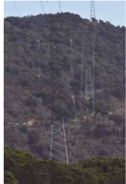
La mateixa torre a mig pintar; ja s'observa un gran contrast entre la zona pintada i la que encara manté la coloració metàl·lica
