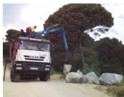
Col·locació de pedres per tancament
