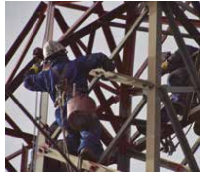
Operaris d'Endesa fan la imprimació prèvia a la coloració de les torres
