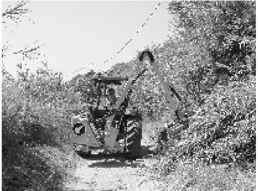
Treballs de desbrossament
