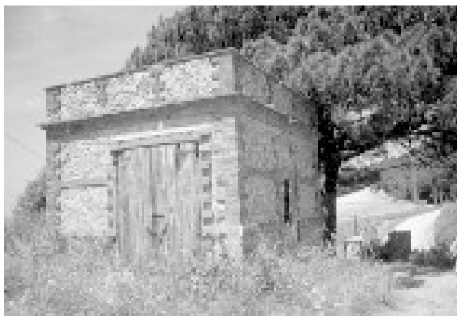
Estat del refugi de can Boquet abans dels treballs de rehabilitació.
