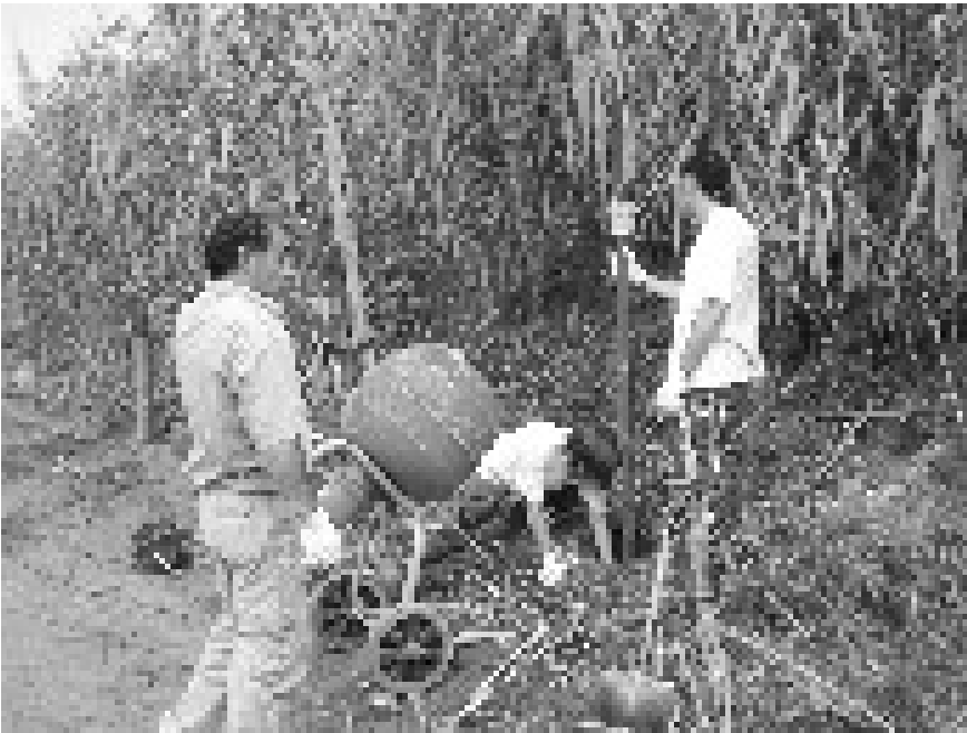
Instal·lació de la tanca de Can Bartrina (Cabrera de Mar)
