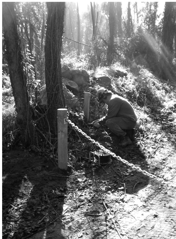
Treballs de manteniment
