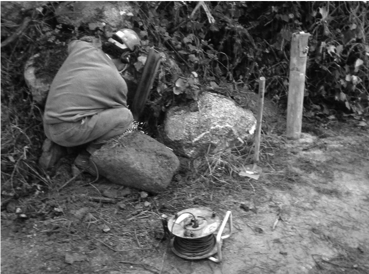
Treballs de manteniment
