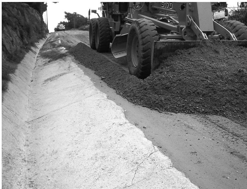
Treballs d'arranjament de la capa de rodolada a la pista carenera entre can Boquet i la Roca d'en Toni (Vilassar de Dalt)
