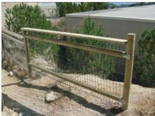
Reparació de la tanca al voltant de l'Observatori astronòmic de Tiana
