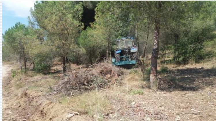
Des-compactació i sembra dels terrenys
