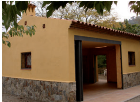
Obres de condicionament del local del Punt d'informació de l'Àrea d'Esplai de la Font de l'Alzina
