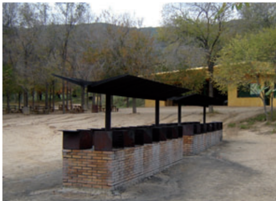
Obres d'ampliació de la zona de les barbacoes, a l'Àrea d'Esplai del Berenador de Can Ruti
