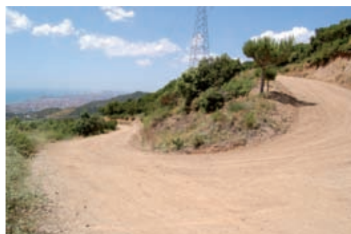
El camí cap a torre Alfa després de passar l'anivelladora
