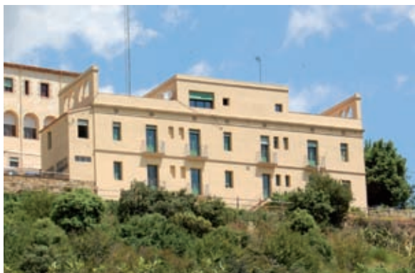
El Centre de Gestió després de les obres
