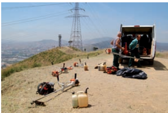
Treballs de creació de franja de seguretat als volts de torre Carlie
