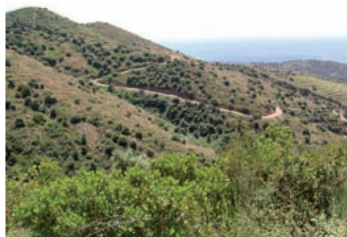
Un brançal del camí de Nou Pins, a Tiana, que pertany a la xarxa viària secundària del Pla director d'infraestructures de prevenció d'incendis
