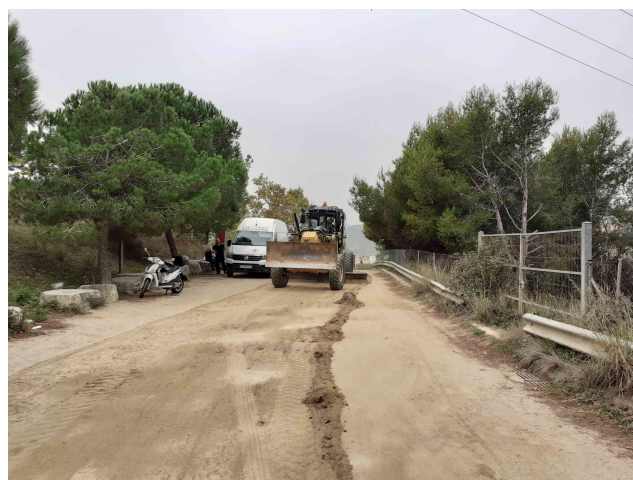
Reparació del camí de Sant Jeroni a la tardor. Foto: Arxiu XPN
