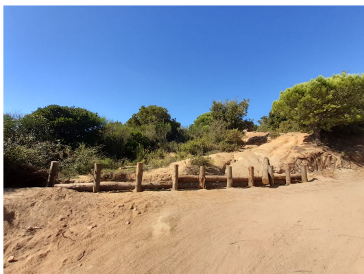
Consolidació de la part baixa del talús. Foto: Arxiu XPN
