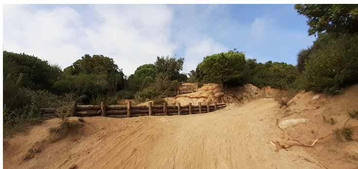
El talús reparat. Foto: Arxiu XPN.
