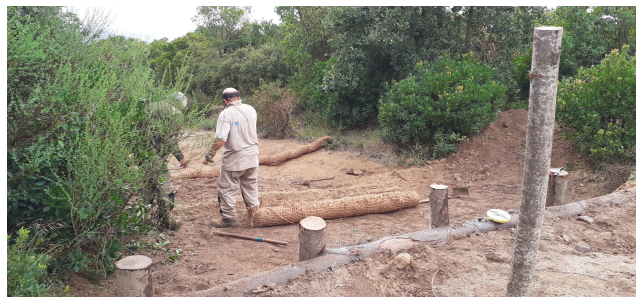
Una línia de palissada i rolls d'escorrentiu. Arxiu XPN
