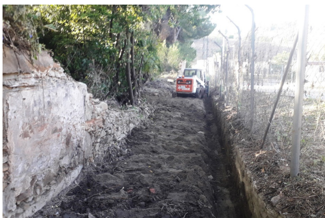
Bobcat traient sediments de la riera de Can Zam. Foto: Arxiu XPN
