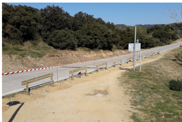
Vista general del tancament. Foto: Arxiu XPN
