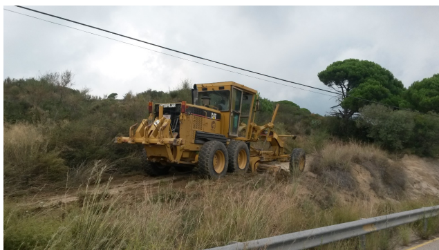
Treballs de manteniment a Montcada i Reixac. Foto: Arxiu XPN
