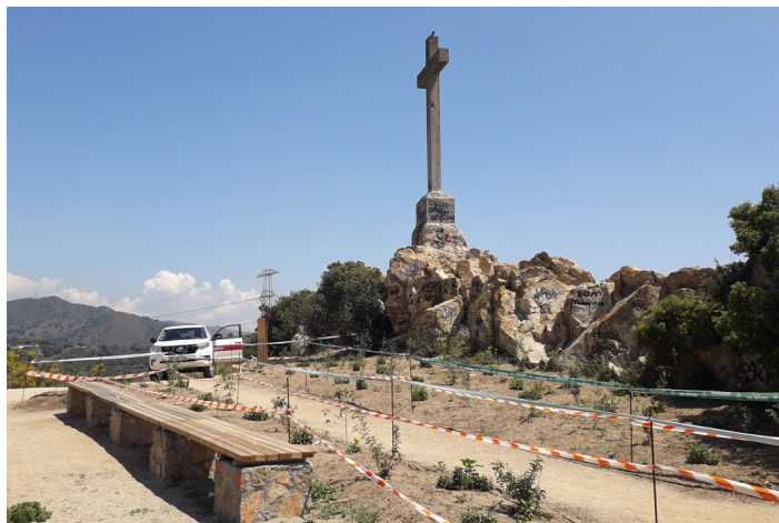
Construcció de banc de pedra i fusta sota la creu de Montigalà. Foto: Arxiu XPN
