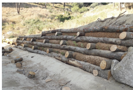
Entramat simple amb rols de fibra de coco al camí antic d'Alella. Foto: Arxiu XPN
