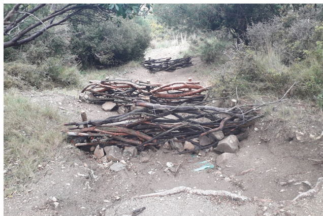
Mitigació de processos erosius a les zones de les ermites mitjançant construcció de feixines de fusta seca. Foto: Arxiu XPN
