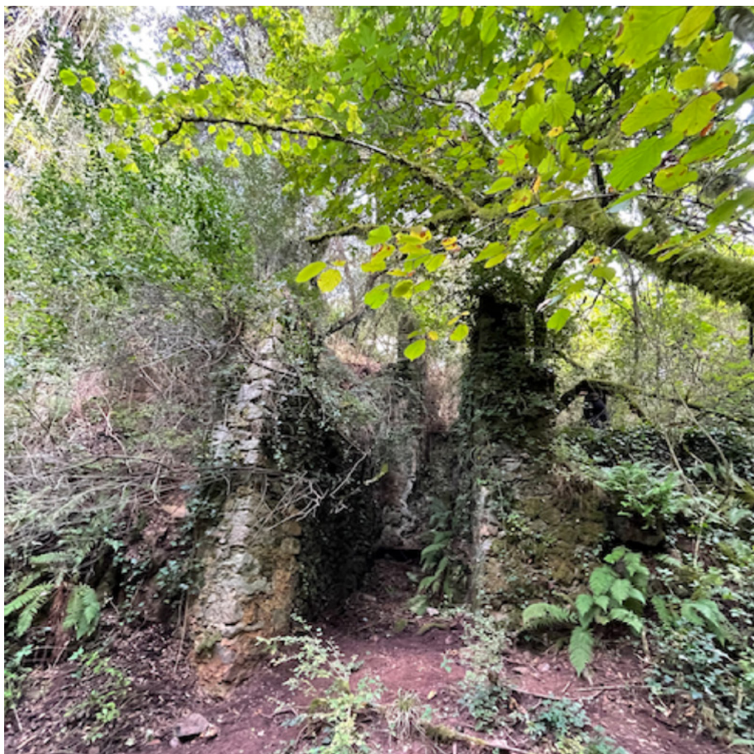
Figura 2. Fotografia frontal dels dos murs que aguantaven la roda
