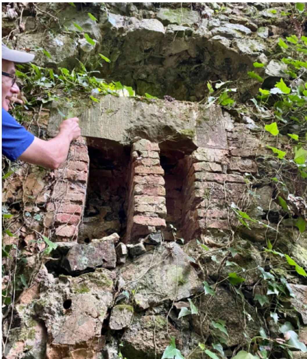
Figura 3. Fotografia dels forats a la paret amb l'arcada
