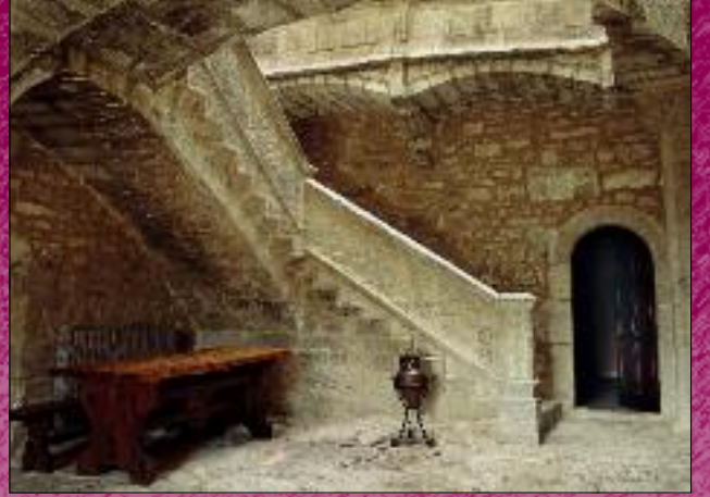
L'escala noble del castell va ser incorporada durant les obres realitzades entre els anys 1917 i 1920.
