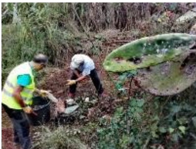
11. Millora ambiental de l'itinerari del torrent de l'Amigó. Parc de la Serralada de Marina.
