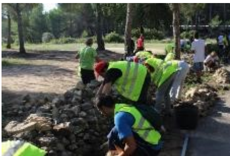
9. Restauració de mur de pedra seca a la Ruta dels Castells. Parc del Foix.
