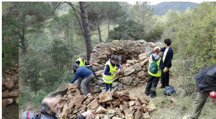
Membres del Cercle construint mur si parets de pedra seca
