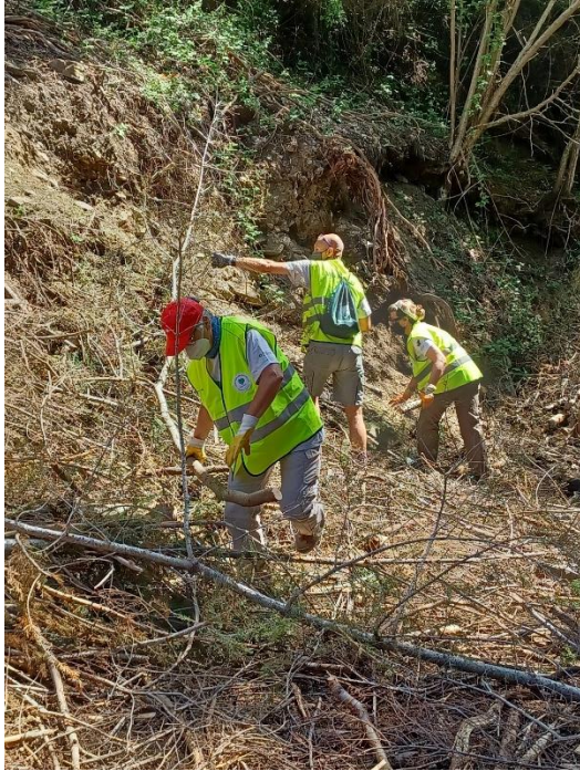
5. Restauració de l'hàbitat de ribera
