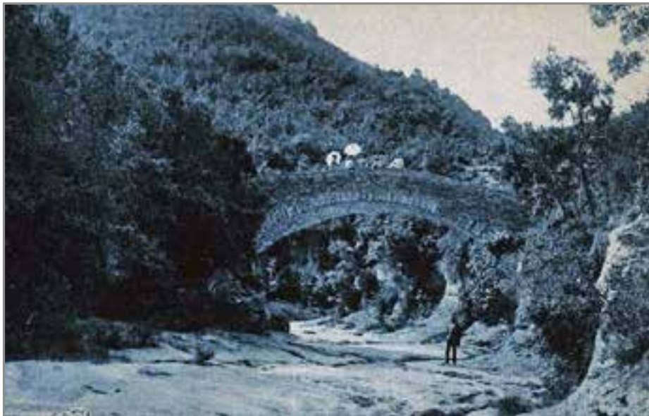
Pont del Rossinyol
