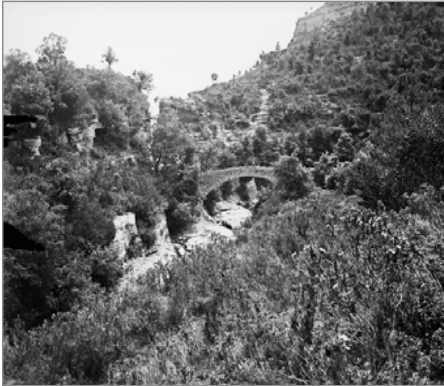
Foto 1. Pont del Rossinyol
