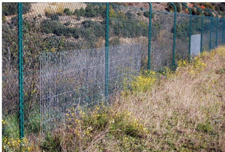
Figura 2.2. Reforç d'un tancament de malla de torsió mitjançant malla electrosoldada instal·lada al seu tram inferior.
