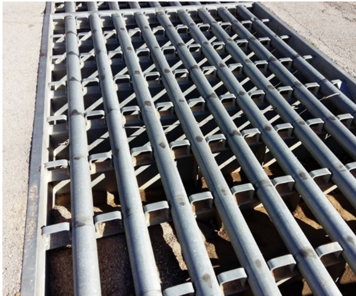
Figura 1.5. Pas canadenc per evitar entrades d'ungulats en interseccions amb camins.
