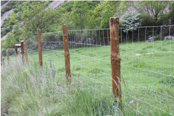
Figura 1.2. Tancament amb malla nuada de densitat progressiva i pals de subjecció de fusta, adequat per a entorns rurals. La malla ha d'estar soterrada a una fondària de 20 cm com a mínim.
