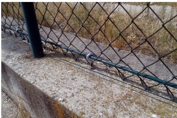
Figura 2.6. Ancoratge de la malla a un muret mitjançant una vara metàl·lica horitzontal.
