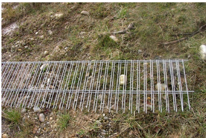
Figura 2.3. El fil horitzontal de la base de la malla de reforç s'ha de tallar de manera que permeti clavar-lo amb més facilitat al terreny.
