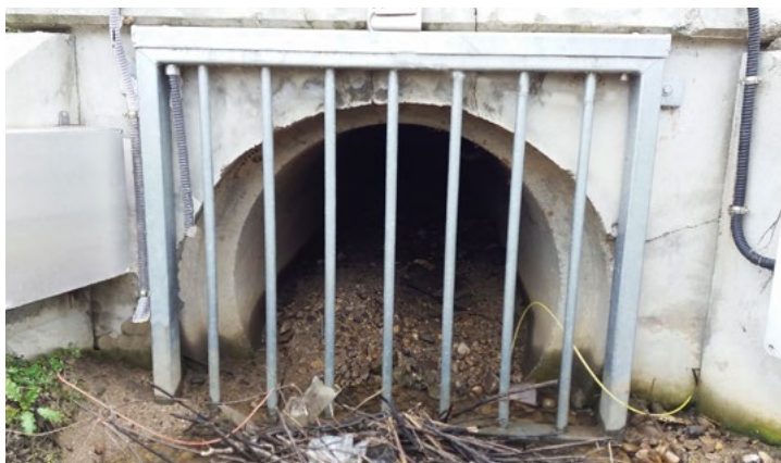
Figura 1.6. Protecció d'un drenatge per evitar accés de senglars a una zona amb tancament perimetral.
