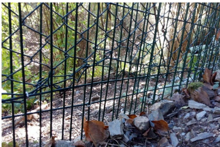
Figura 2.4. Reparació de desperfectes d'una malla de torsió amb reforç de malla electrosoldada adequat per a senglars.
